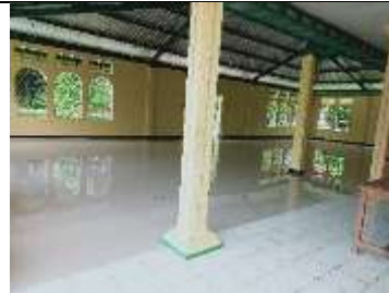
Ruang Tambahan Masjid Gemelaha Majira UNPATTI
