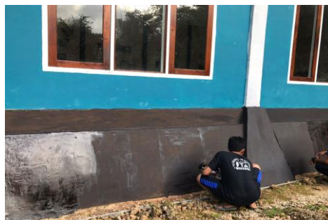
Gambar 2. Proses Finishing Pada Pekerjaan Pondasi Gedung Raja Manguntu
